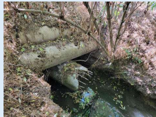
Водопропускное сооружение плотины (РПС №3) на р. Бейсуг. Нижний бьеф
